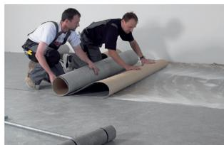
UZIN LE 44 erfüllt im System mit Linoleumbelägen der Armstrong DLW AG und der Forbo Flooring GmbH den Nachweis der Schwerentflammbarkeit nach DIN EN 13 501 – 1. Die entsprechenden Zertifikate können beim Belagshersteller angefordert werden.
