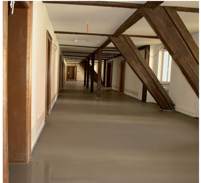
In dieser historischen Klosteranlage mit Klinikbetrieb wurde UZIN NC 170 LevelStar auf schwierigste Untergründe in unterschiedlichen Dicken verarbeitet. Das Ergebnis ist eine perfekte Oberfläche mit bestem Verlauf und selbstverständlich ohne Risse.
