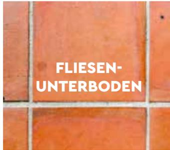
**SPIRIT GlueDown kann nur auf einem stabil eben ausgeglichenen Untergrund verlegt werden**, da sich alle Fugen zwischen den Keramikfliesen auf den neuen Bodenbelag übertragen. Eine direkte Verlegung auf einer nicht nivellierten Fläche von Keramikfliesen wird nicht empfohlen!
