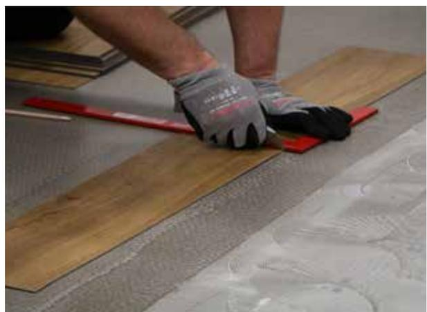
Wenn der Belag in einem Abschnitt verlegt wurde, sollte der Bodenbelag in beide Richtungen mit einer ca. 45 kg schweren Bodenwalze angerollt werden, um eine gute Kleberübertragung zu gewährleisten. Alle Kleberrückstände sollten sofort mit einem feuchten Tuch entfernt werden. Auf keinen Fall Reinigungsmittel verwenden. Für den Rest des Raumes wird genauso vorgegangen.
