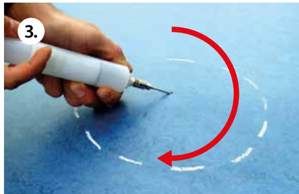
**Eurocol Linoleum Doctor** sparsam in die zu reparierende Fläche einspritzen. Während der Einspritzung wird die Injektionsspritze kreisförmig bewegt.
