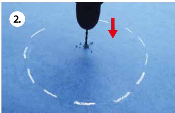
Bodenbelag etwa in der Mitte der zu reparierenden Fläche mit 4 mm Bohrer anbohren.
