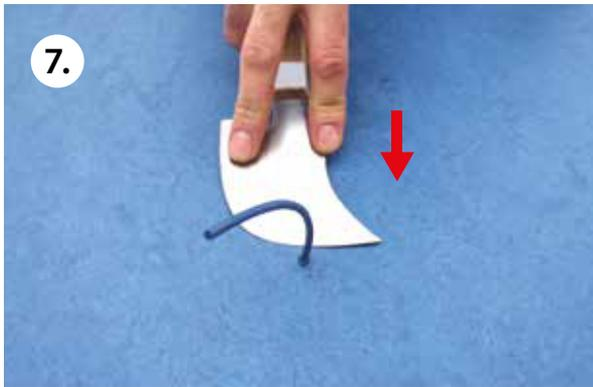
Farblich passenden Linoleum-Schmelzdraht erwärmen und in das Bohrloch einführen, überstehenden Schmelzdraht abstoßen.
