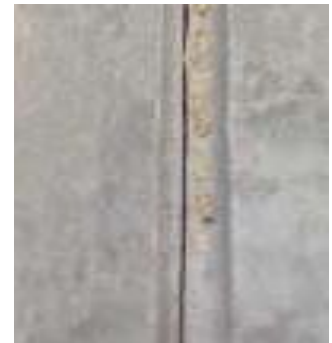
Fräsung außermittig einseitig schlechte Haftung
