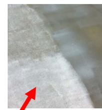
Strukturierte Oberfläche (grobe „Orangenhaut“) nach Auftrag der Haftfixierung mit grobporiger Schaumstoffrolle und vollständigem Abtrocknen.
