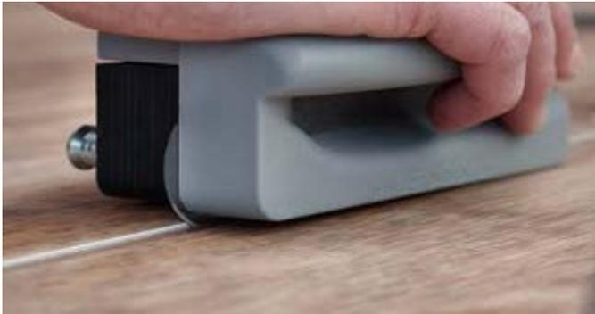
Bei thermischer Verfugung sind die Bahnen so zu beschneiden, dass beiderseits die „Holzfuge“ entfernt ist und dadurch keine doppelte „Holzfuge“ entsteht, diese bildet dann der Schweißdraht. Nach dem Nahtschnitt werden die Bahnen ca. zur Hälfte in Längsrichtung zurückgeschlagen und der Klebstoffauftrag kann erfolgen.
