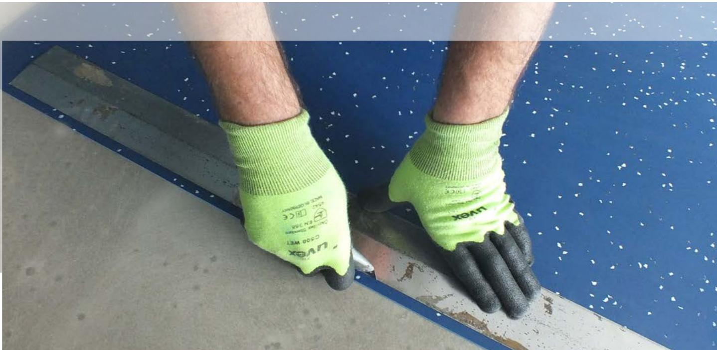
Step Sicherheitsbeläge von Forbo können auf jeden verlegereifen Untergrund verlegt werden. Der Untergrund muss fest, tragfähig, dauertrocken und eben sein.
