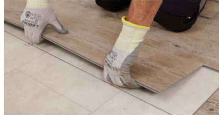
Verlegung auf vorhandenen Fliesenböden Direct installation over existing floor
