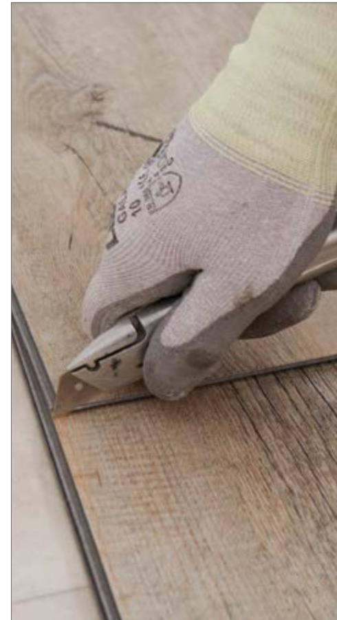
Leichter Zuschnitt mit einem Verlegemesser Easy cutting
