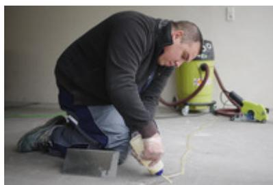
Nach dem auffräßen, absaugen und einlegen der Estrichklammern wird UZIN KR 516 zielgenau in der Fuge appliziert.
