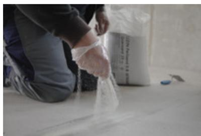
Glattgestrichenes UZIN KR 516 muss im frischen Zustand mit UZIN Perlsand 0.8 abgesandet werden.
