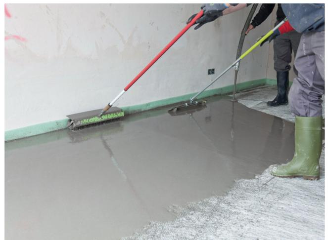
UZIN NC 160 lässt sich sowohl mit der Glättkelle als auch mit der Raketentechnik mühelos verarbeiten. Das Pulver schließt schnell und klumpenfrei auf und die sehr guten Verlaufeigenschaften stellen immer eine hervorragende Basis für alle Folgearbeiten dar. Egal ob im Neubau oder auf Altuntergründen im Renovierungsbereich.
