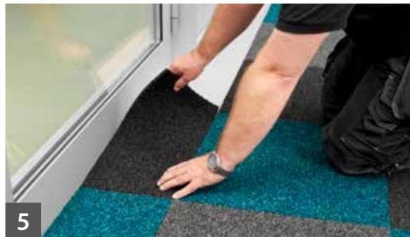
5 Die untere Fliese wird mit der Trapezklinge angeschnitten und nach Entfernen der oberen Fliese durchtrennt.
