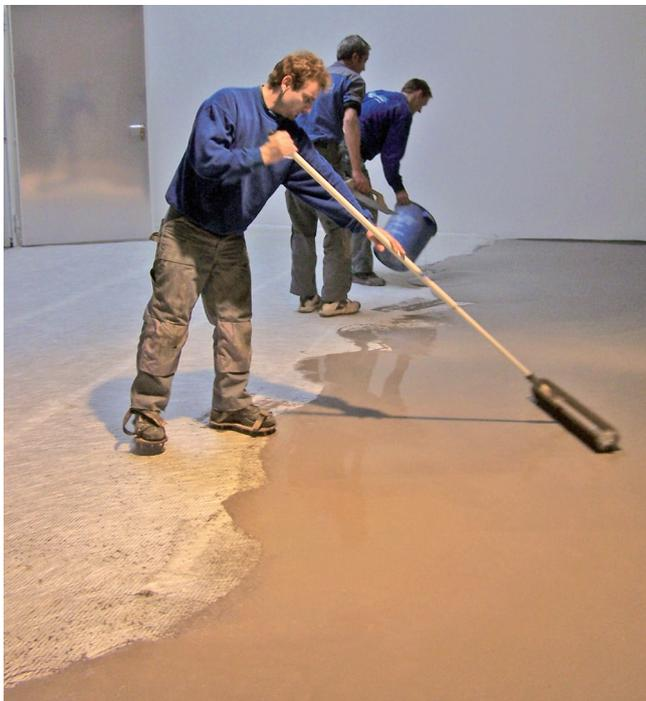
Verarbeitung von UZIN NC 170 LevelStar auf lose ausgelegtem Renoviervlies UZIN RR 201 auf mit UZIN RR 203 vorbereiteten rissanfälligen Untergrund.
